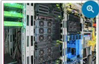
FIG. 4 Les ventilateurs d'une armoire de centre de données permettent la dissipation de la chaleur produite par effet Joule.
